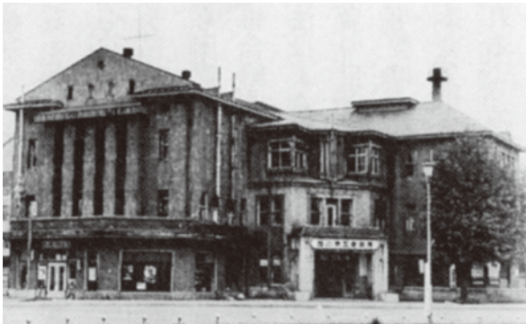
旭川商工奨励館(前会館)
