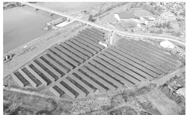
旭川北都ソーラー発電所
