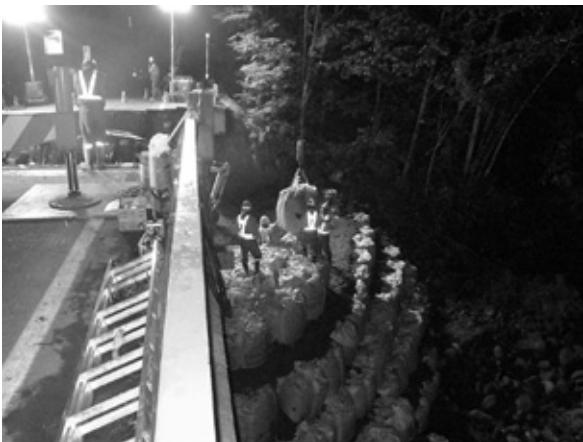
災害復旧作業の様子
