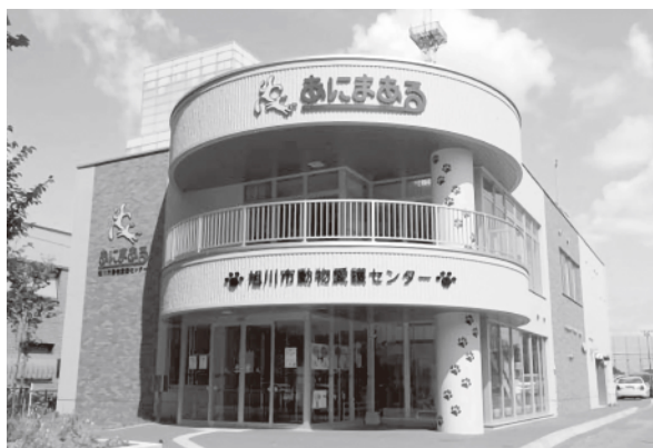
令和元年度現在の旭川市動物愛護センターの外貌
