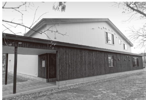
完成した「公設民営型酒蔵」東川町
